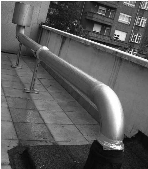
Fig.12. Salida de evacuación del Helio
